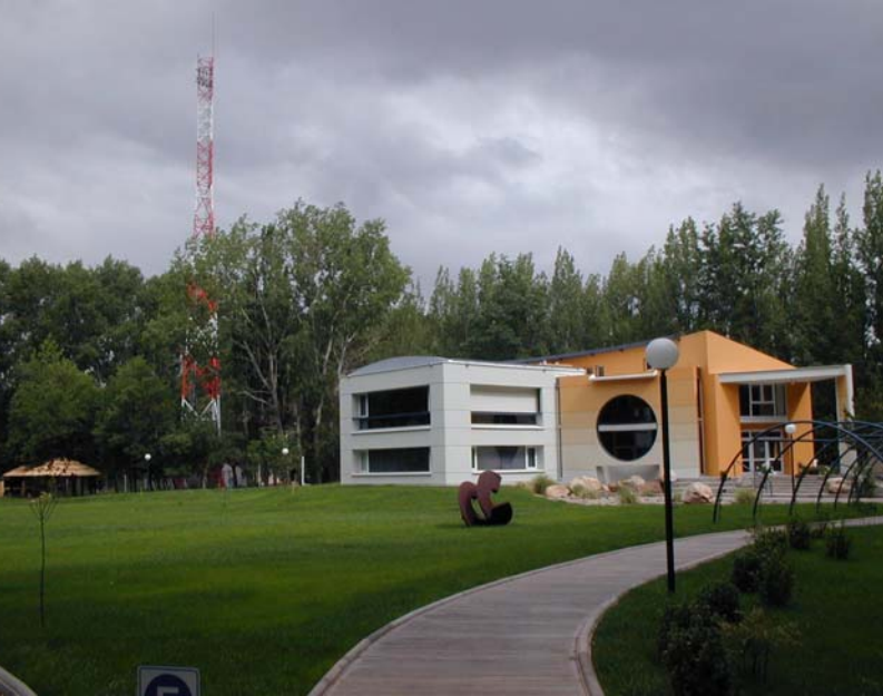
Edificio de oficinas, Centro de Datos y Centro de Visitantes
