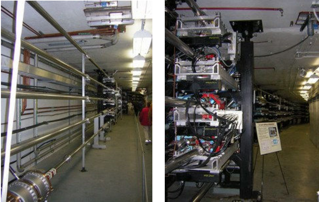
Figura 1.2 - Fotografías del túnel del acelerador de electrones del Jefferson Lab (NewPort News, USA). Se aprecian los cinco distintos recorridos que realiza el haz de electrones en función de su energía.
