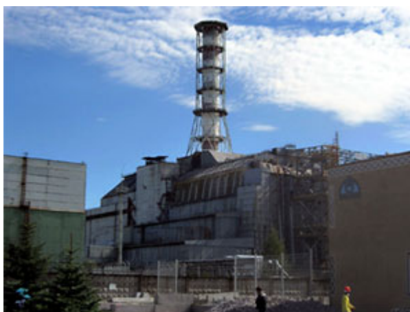
Estructura de hormigón denominada 'sarcófago', diseñada para contener el material radiactivo del núcleo del reactor de Chernóbil. / Carl Montgomery
